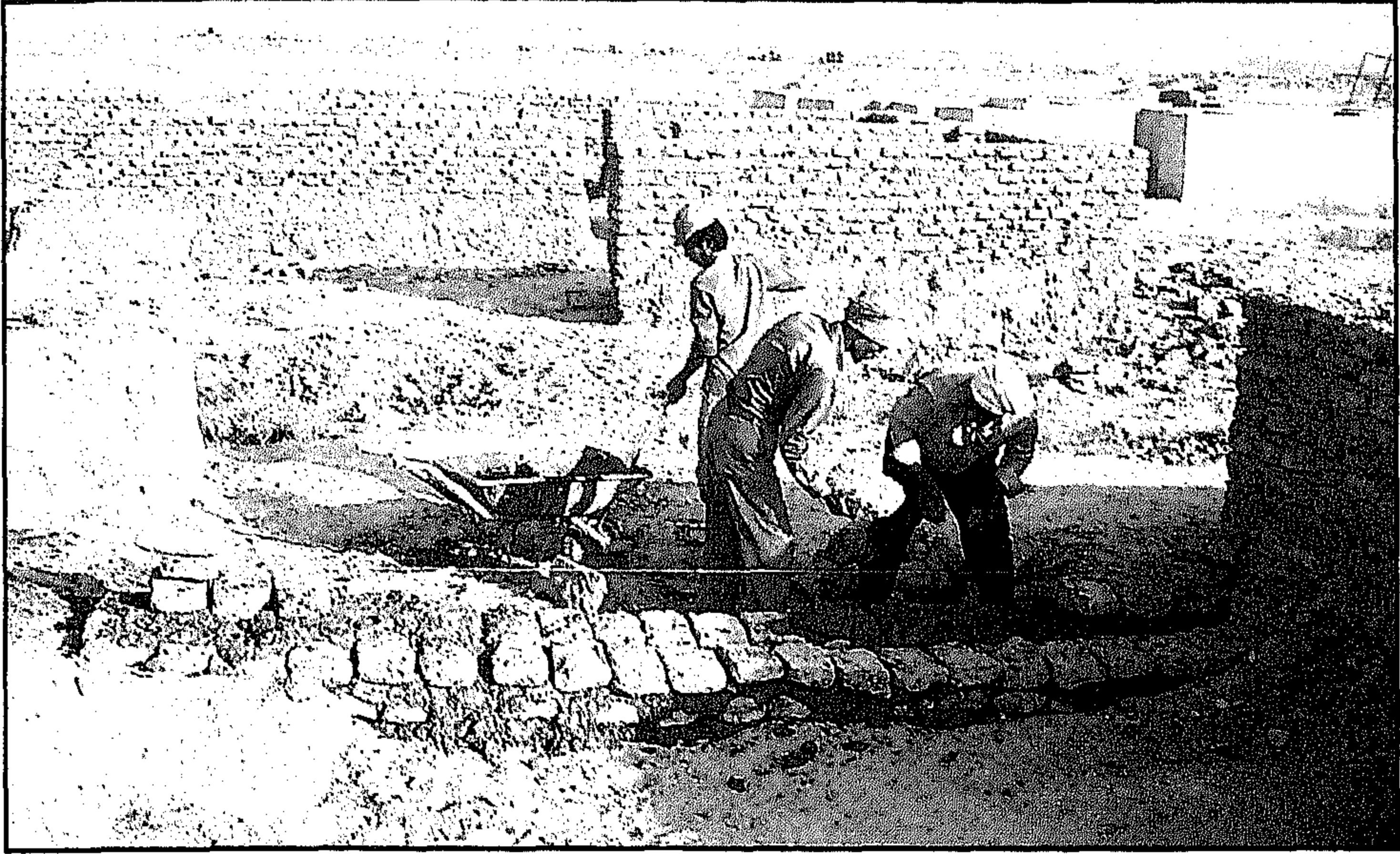
صورة رقم ٤١ * صورة لأعمال الترميم باللبن لأسس جدران المباني .
